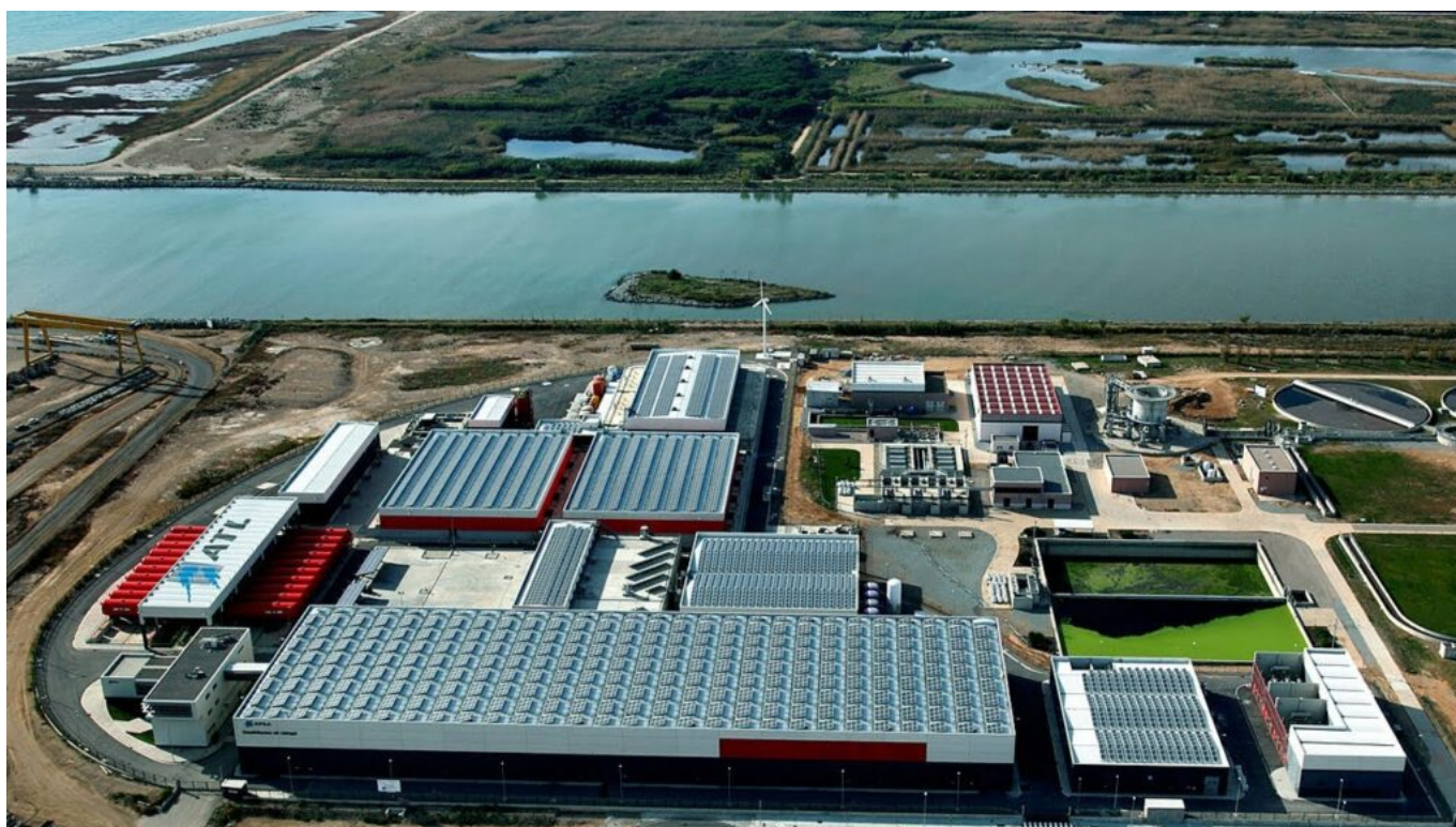
Dessalinitzadora del Prat de Llobregat / ENS D'ABASTAMENT D'AIGUA TER-LLOBREGAT (ATL)
